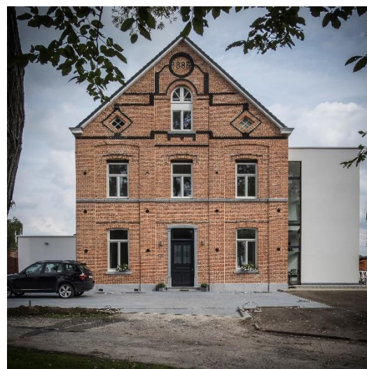
Hombeek verbouwing en uitbreiding woning
